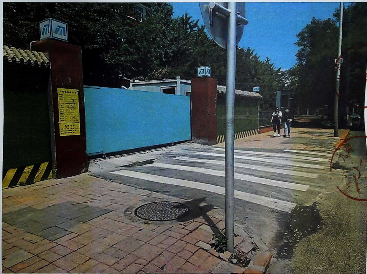
团结湖3号竖井东侧新设大门侧面照片
