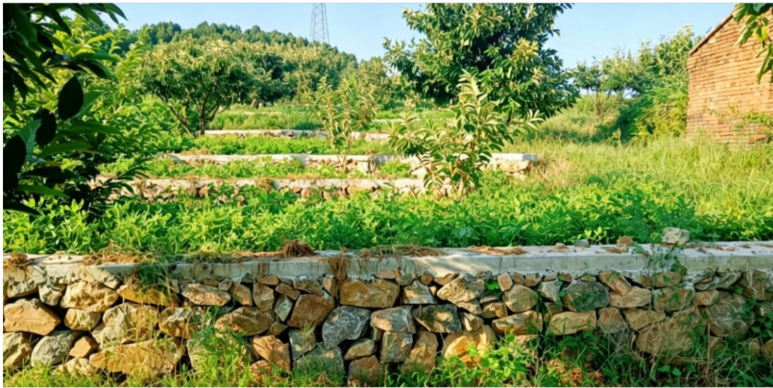
图3-9 密云水库上游流域林地水土流失防治工程（干砌石挡墙）
