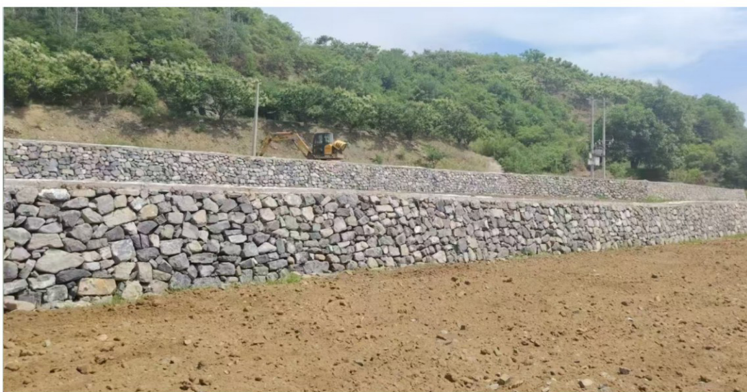
图3-12 燕山山地综合治理工程—石坎梯田（查子沟小流域）
