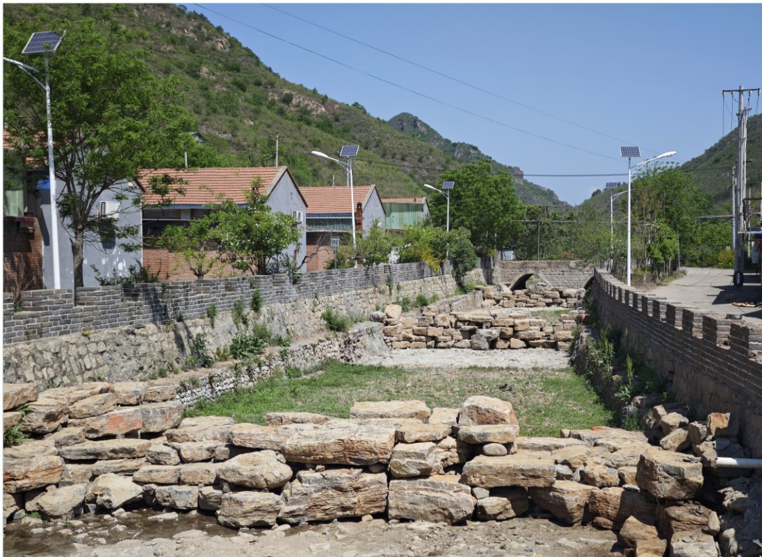
图3-3 苏家峪小流域溢流坝改造
