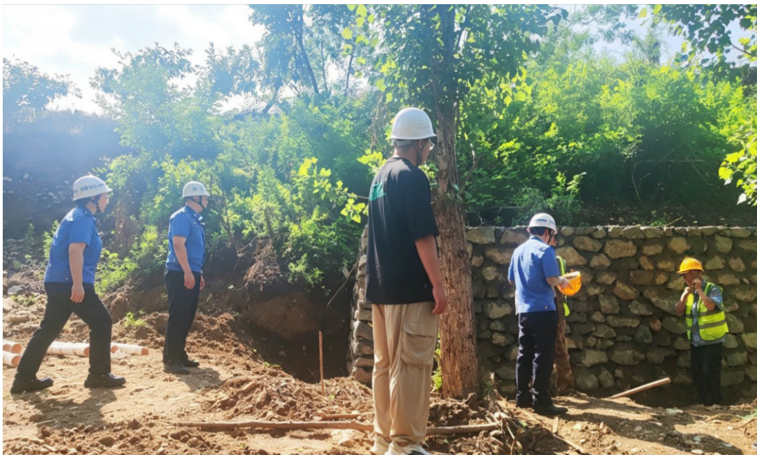
图3-10 区城管执法局对上游林地项目开展现场检查
