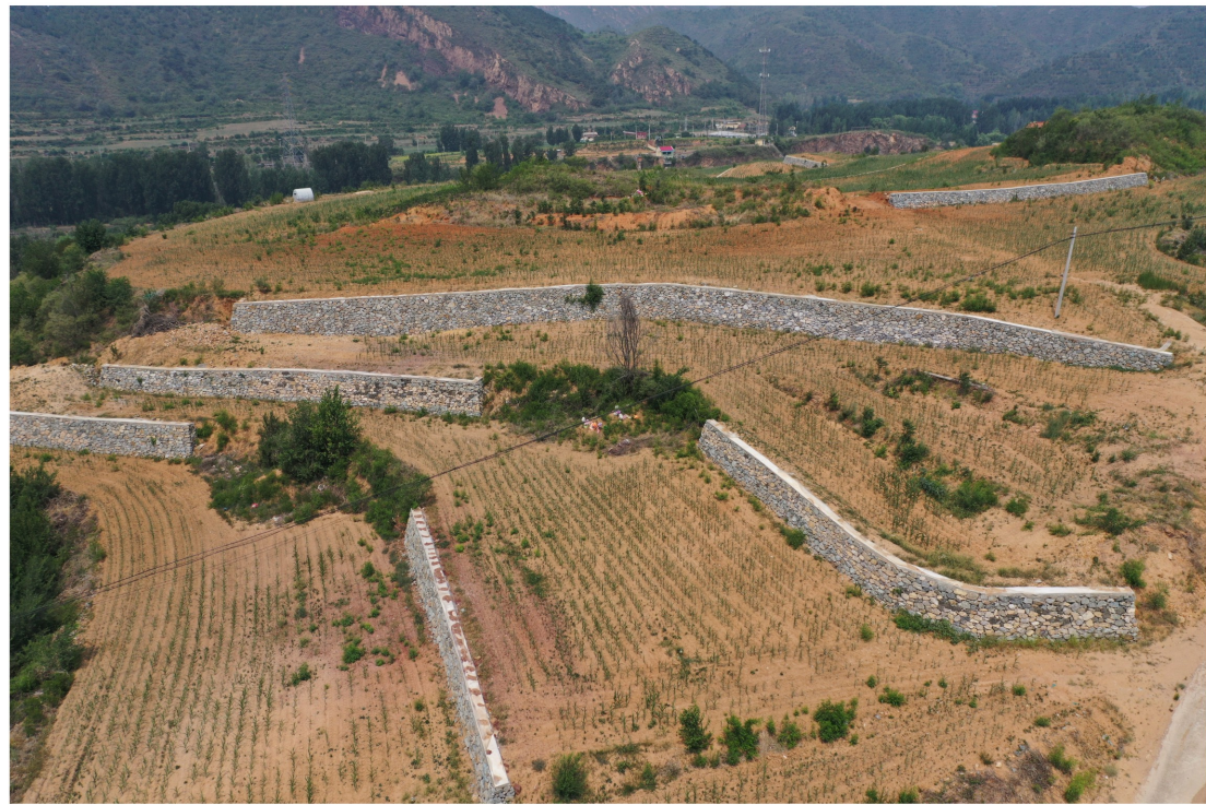
图3-4 南台小流域挡土墙
