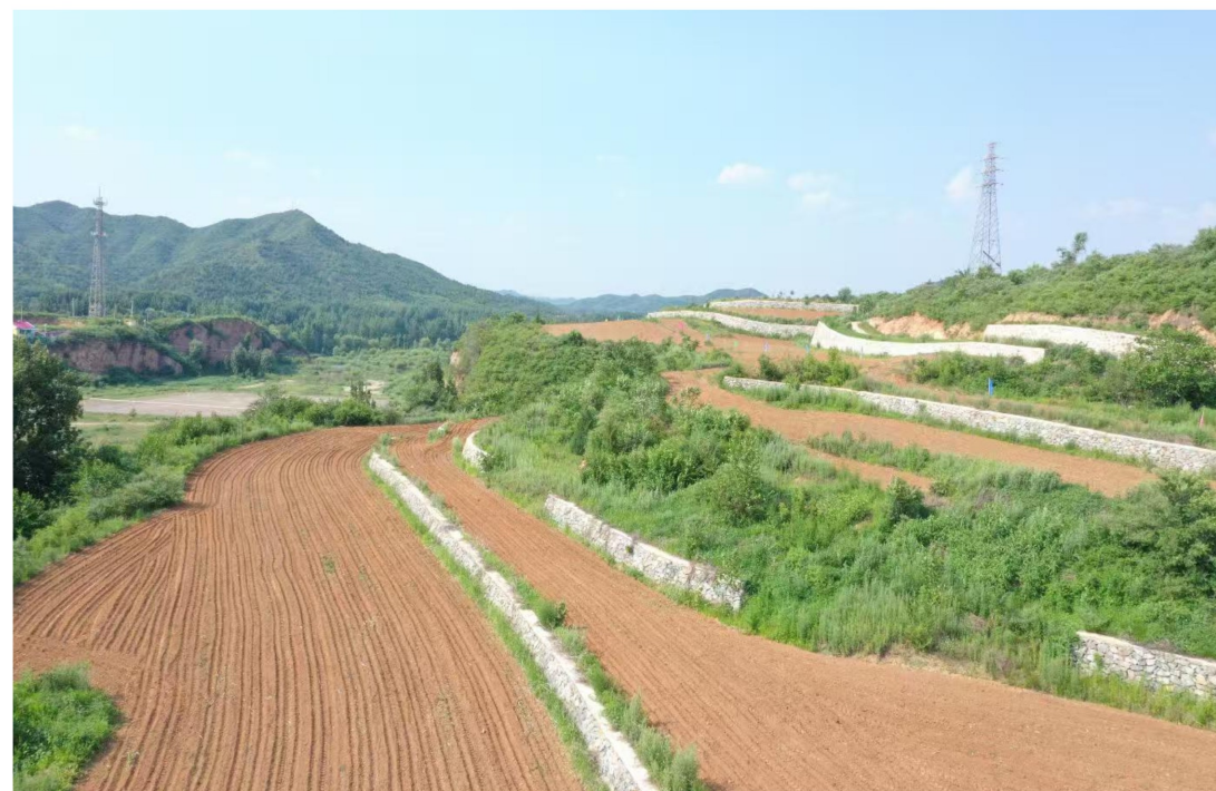
图3-7 北京市密云区燕山山地南部生态综合治理项目现场施工效果图
