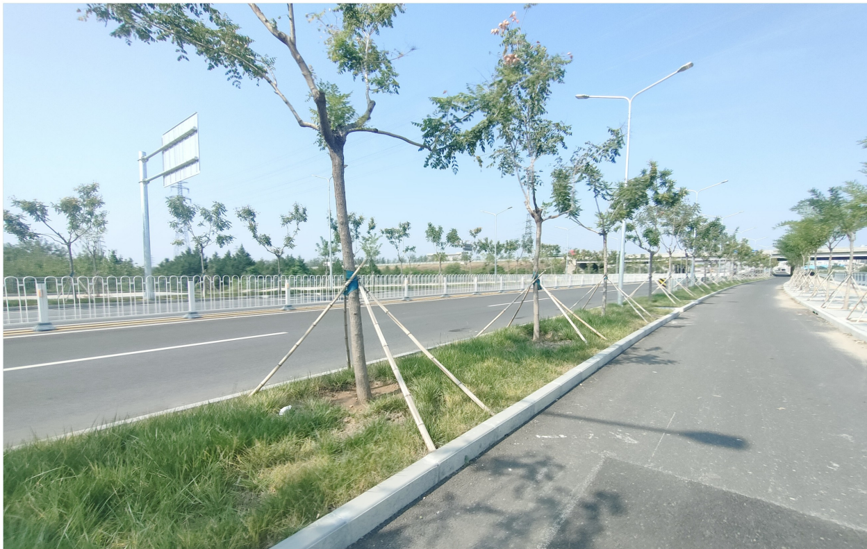
图2-3 密三路（潮河右堤路-东白岩）扩建工程（水土保持措施落实后）
