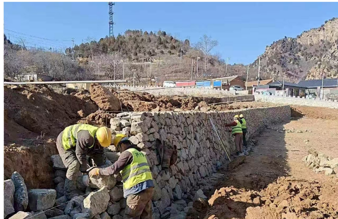
图3-6 北京市密云区燕山山地南部生态综合治理项目现场施工现场
