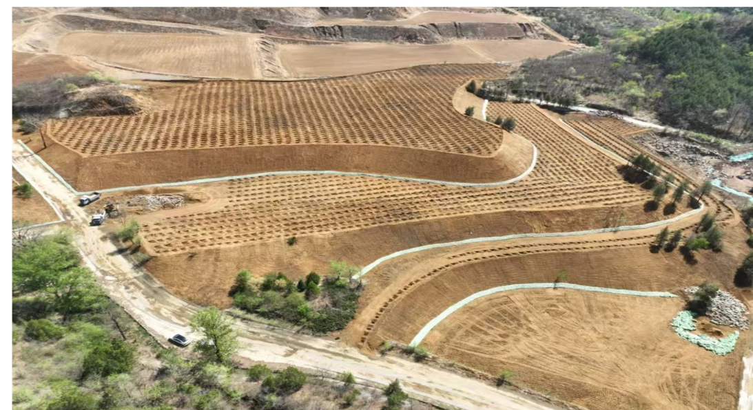
图3-10 密云水库上游流域矿山防洪安全治理工程现场施工
