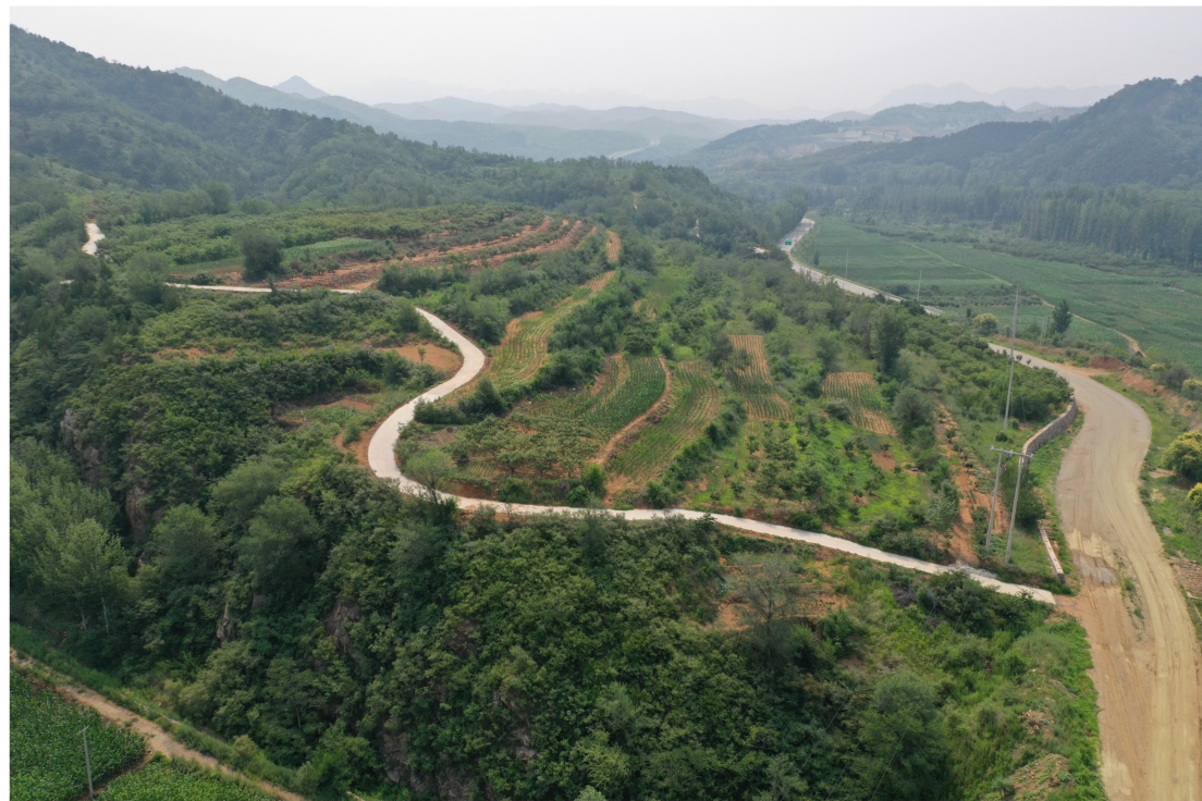
图3-3 达岩小流域田间生产道路
