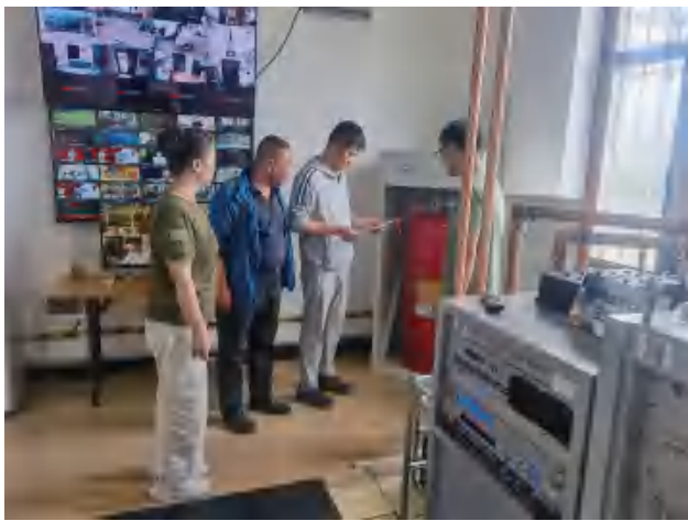
9月26日，区融媒体中心不老屯转播站开展安全检查 （丛 杉 摄）
