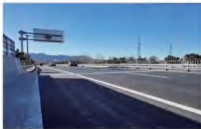
11月30日，新农村立交桥危桥抢险改造工程完工通车 (鲍伟 摄)
