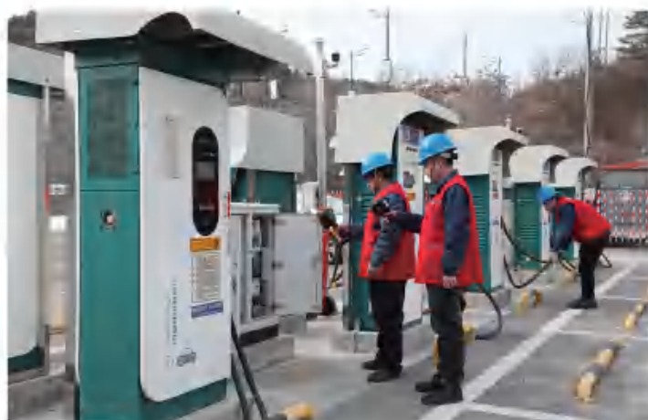
2月5日，国网北京密云供电公司古北口供电所运维人员对古北水镇景区新能源汽车充电桩配套供电 (密云供电公司 供图)
