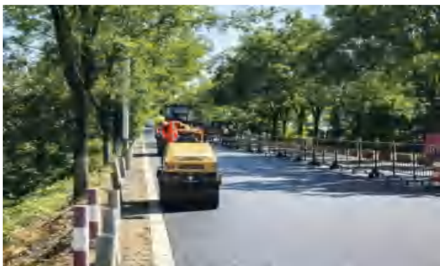
9月23日,密三路(K0+000—K18+520) 修复养护工程施工中 (白运安 摄)
