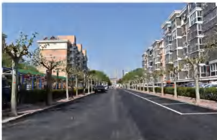
4月17日，嘉益园小区路面改造工程完工 (密云建工集团 供图)
