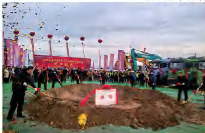
12月19日，怀柔科学城东区集租房建设工程开工奠基仪式举行 (北京燕安保障房公司 供图)
