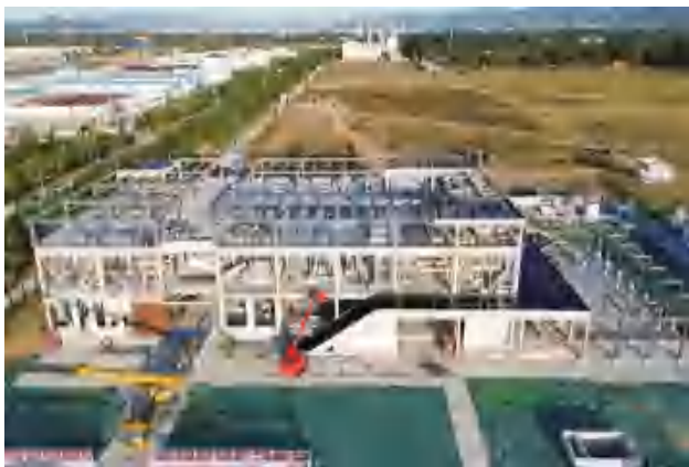
10 月 11 日，北京大学怀密医学中心食堂/能源中心项目施工现场 (北京大学医学部 供图)
