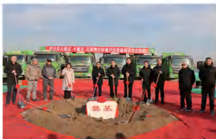
12月24日，密云镇大唐庄、小唐庄、王家楼三村棚改项目回迁地块土方工程、基坑支护、降水工程开工 (柴小月 摄)
