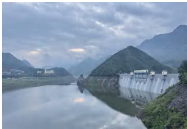
7月，遥桥峪水库除险加固工程后实现蓄水 (区水务局 供图)
