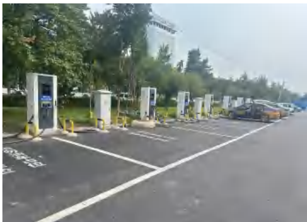
7月4日，开发区停车场充电桩安装成功
