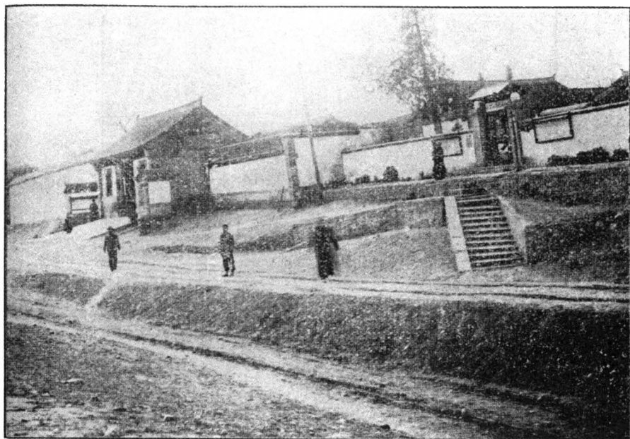
承審處＝縣政府正門左端ノ堀ハ監獄ナリ 皆昨午修繕終ヘタリ
