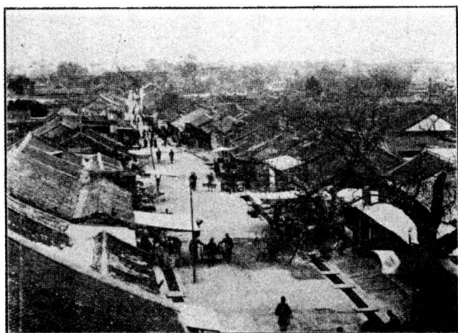
民國二十七年四月二十日撮影 縣城鼓樓ヨリ南大街ヲ望ム 縣内隨一ノ繁華街ナリ 本大街ノ道路工事ハ昨年九、十、 十一、十二月ニワタリ修築セラル 煉瓦造リノ水溝兩側ニアリ 縣内隨一ノ道路 市日ニハ雜踏ヲ極ム
