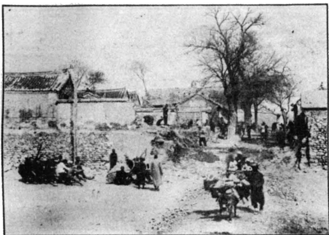
民國二十七年四月二十日撮影 縣城鼓樓西ノ道路取擴ケ工事 中央城壁カ鼓樓ノ跡 該鼓樓ハ民國二十二年ノ北支聖戰ノ折日本軍飛 行機ニヨリ爆撃シ民國二十四年殘骸ヲ取拂ヒ城 壁ト釣鐘ノミ殘ル
